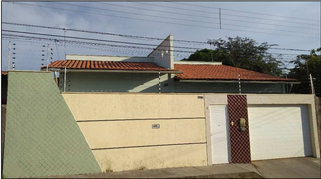
Figura 21 – Fachada da residência
