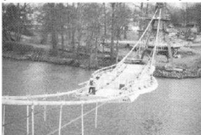
Figura 36 – Segmento central do tabuleiro sendo suportado pelos cabos principais
