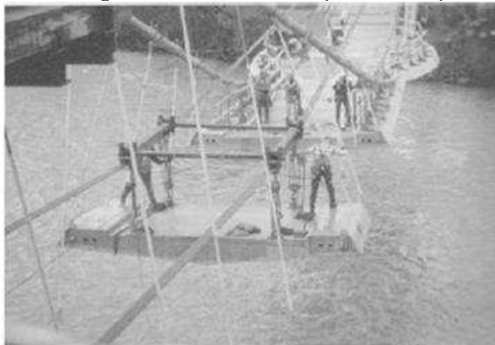
Figura 37 – Montagem do tabuleiro de uma passarela suspensa por cabos
