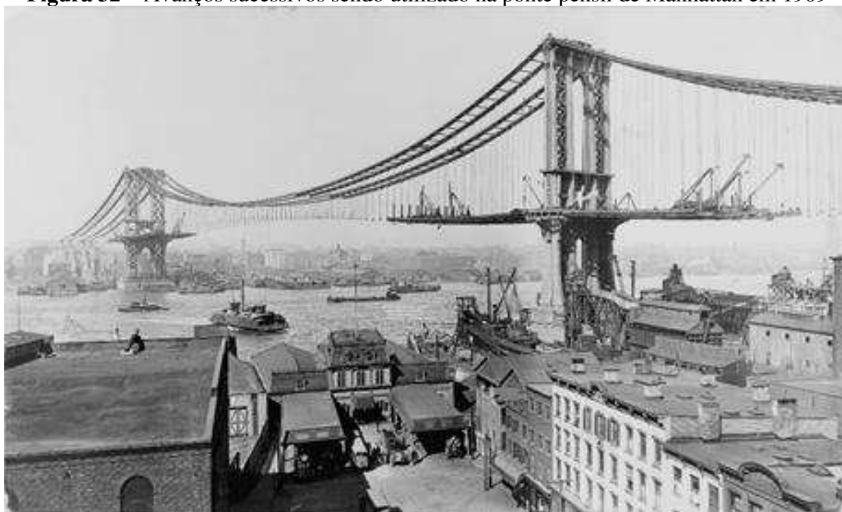
Figura 32 – Avanços sucessivos sendo utilizado na ponte pênsil de Manhattan em 1909
