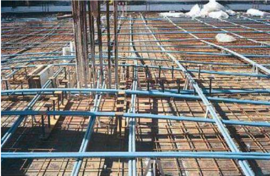
Figura 16 – Vista das armaduras em uma laje lisa protendida
