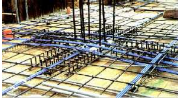
Figura 34 – Detalhe da armadura de punção
