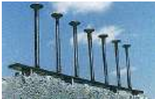
Figura 35 – Detalhe dos conectores
