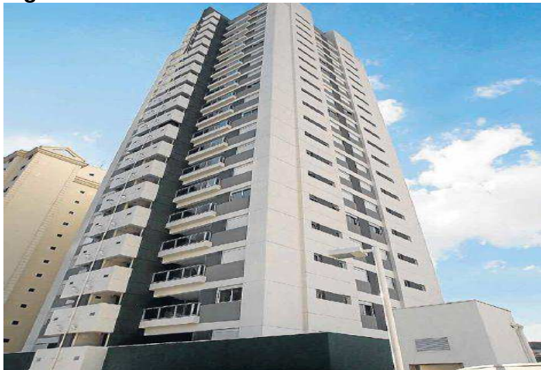
Figura 14 – Edifício True Chácara Klabin
