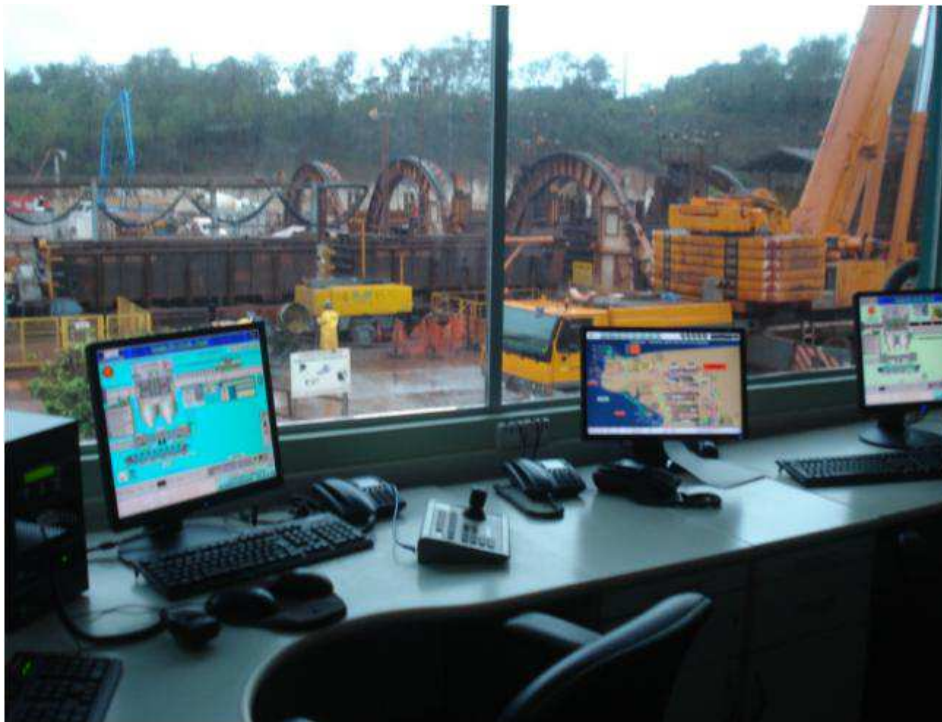
Figura 7 - Sala Operacional dos Viradores de Vagões
