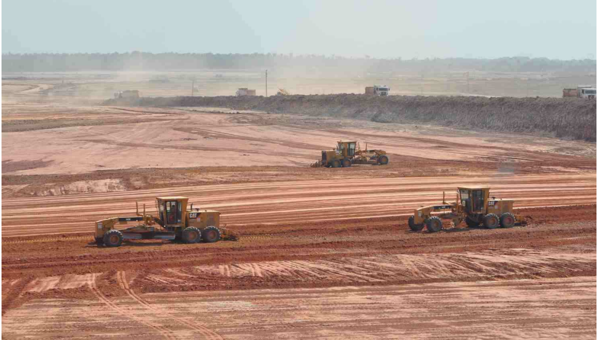
Figura 2 – Etapa inicial de terraplanagem da Refinaria Premium I Fonte: Própria autora visita à obra (Nov./2011).
