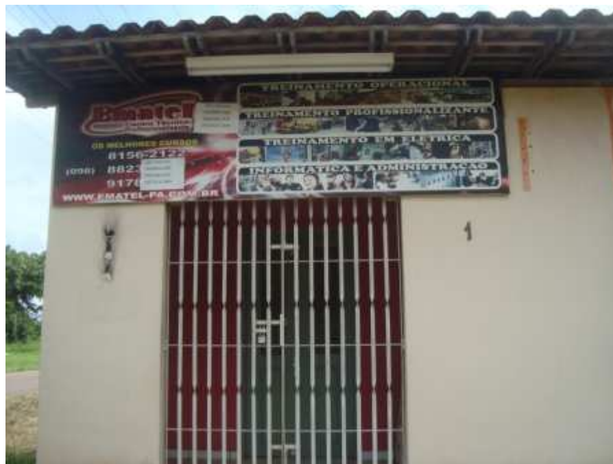
Figura 5 – Casa em Santa Quitéria alugada pela empresa EMATEL. Fonte: Própria autora (maio/2013).
