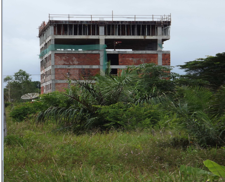
Figura 35 - Hotel em construção no povoado de Santa Quitéria Fonte: Própria autora em coleta de campo (maio/2013).
