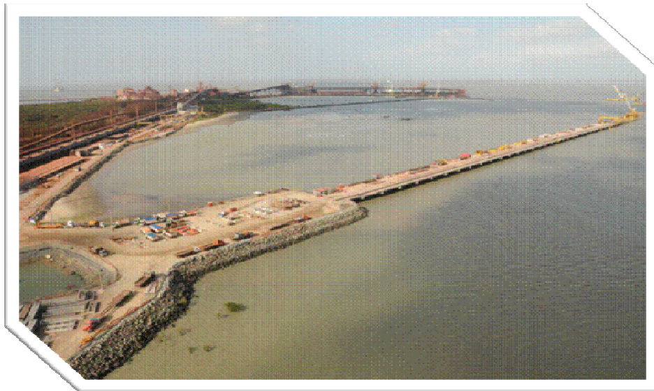
Figura 11 - Obras Pier IV (ampliação do TPPM – Terminal Portuário de Ponta da Madeira) Fonte: II Oficina UFMA- ONU/HABITAT (2012)
