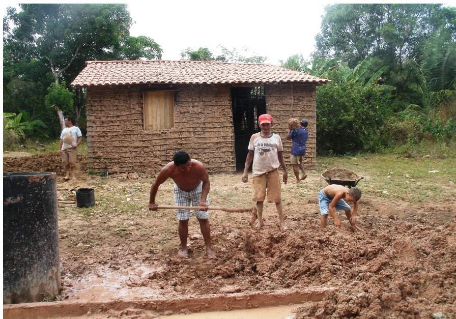
Figura 21 - Mutirão para construção de casa, povoado Zé Pedro, Bacabeira - MA 21
