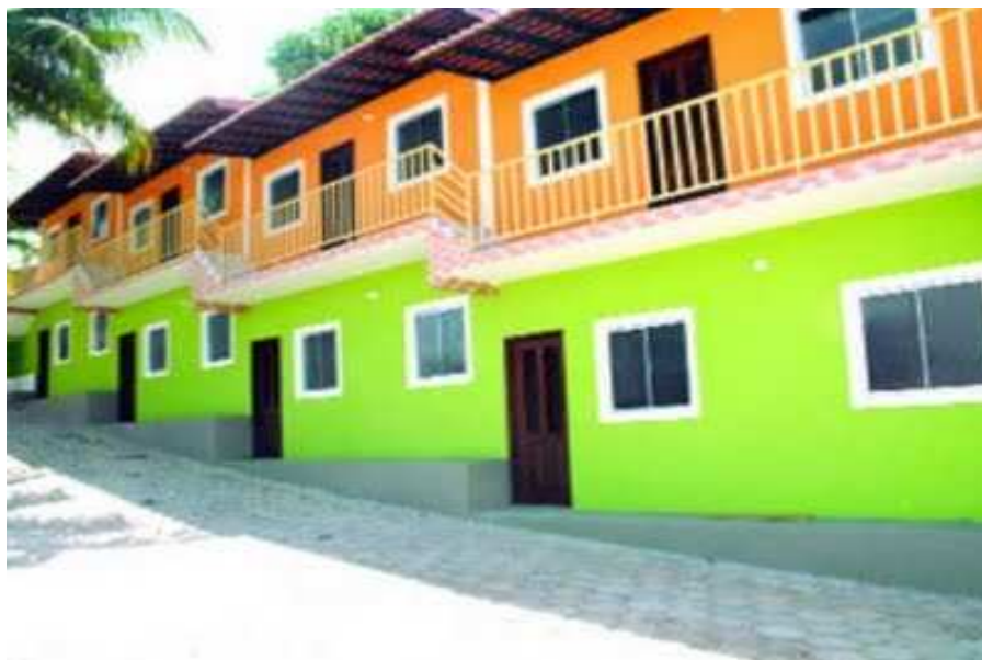
Figura 23 - Conjunto de apartamentos recém-construídos no centro de Bacabeira 22
