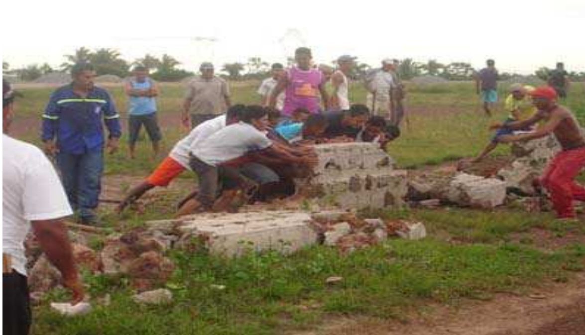
Figura 15 - A queda do muro de Bacabeira-MA.
