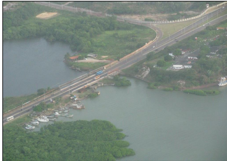
Figura 3 – Barragem do rio Bacanga
