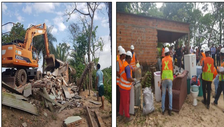
Figura 21 – Derrubada de moradias no Cajueiro
