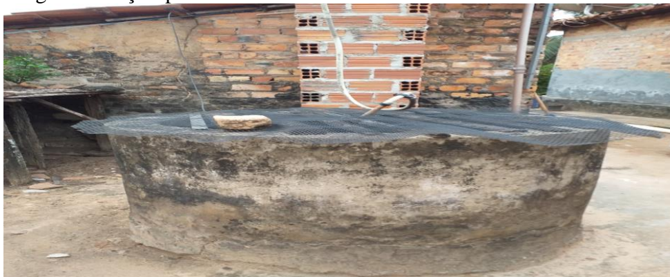
Figura 4: Poço tipo Cacimba
