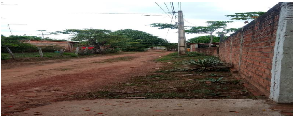
Figura 6: Rua sem pavimentação
