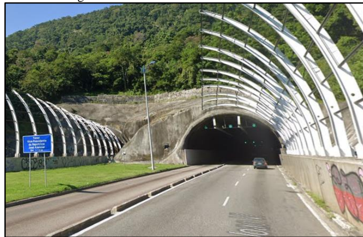
Figura 14 - Visão Frontal da abertura do túnel
