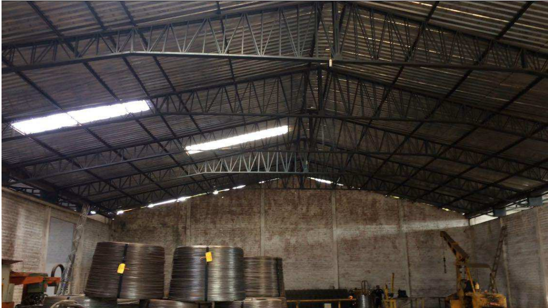
Figura 5.5: Parte interna do galpão
