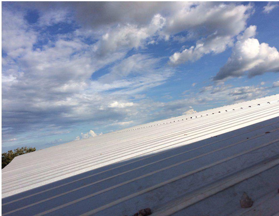
Figura 5.6: Cobertura do galpão
