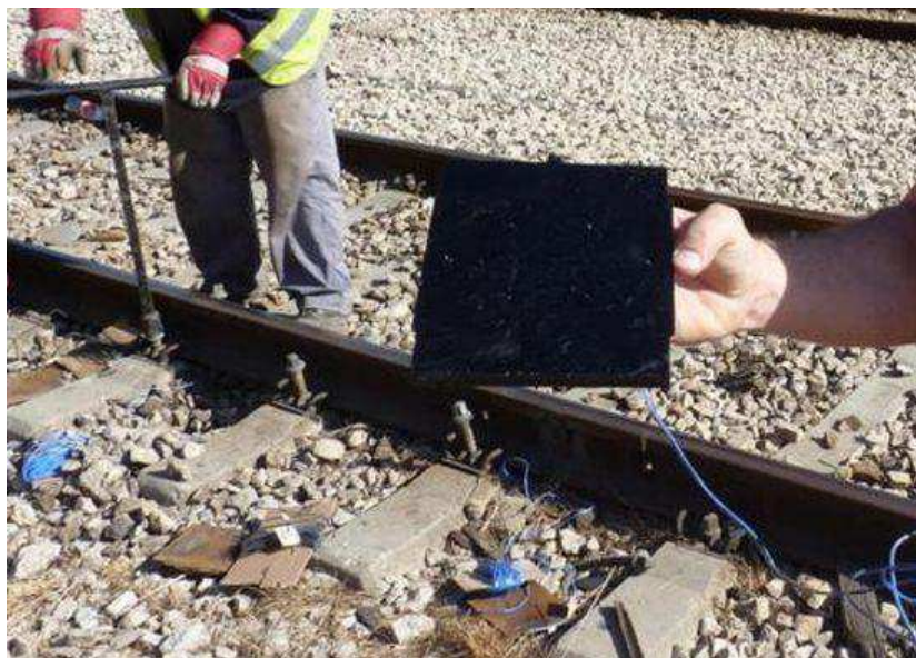
Figura 2.11. Instalação do IPEG PADS piezoelétricos nos trilhos (Sing, 2010)
