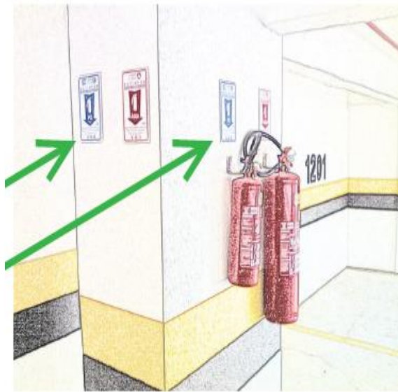
Figura 12 - Extintor Instalado
