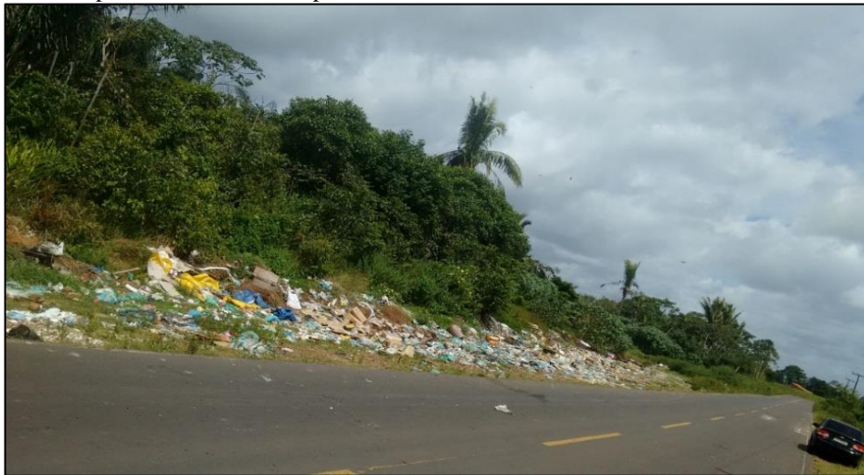
Foto 13 - Superfície aplainada degradada com ocorrência de lixo, rodovia MA - 301 que dá acesso ao Garimpo de Caxias - Município de Godofredo Viana – MA
