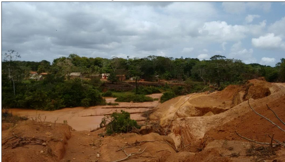
Foto 29 - Residências localizadas próximas à área minerada
