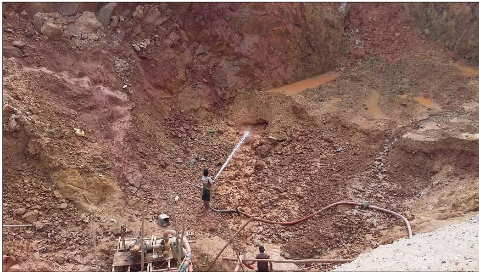
Foto 17 - Atividade de desmorte de encosta do barranco.
