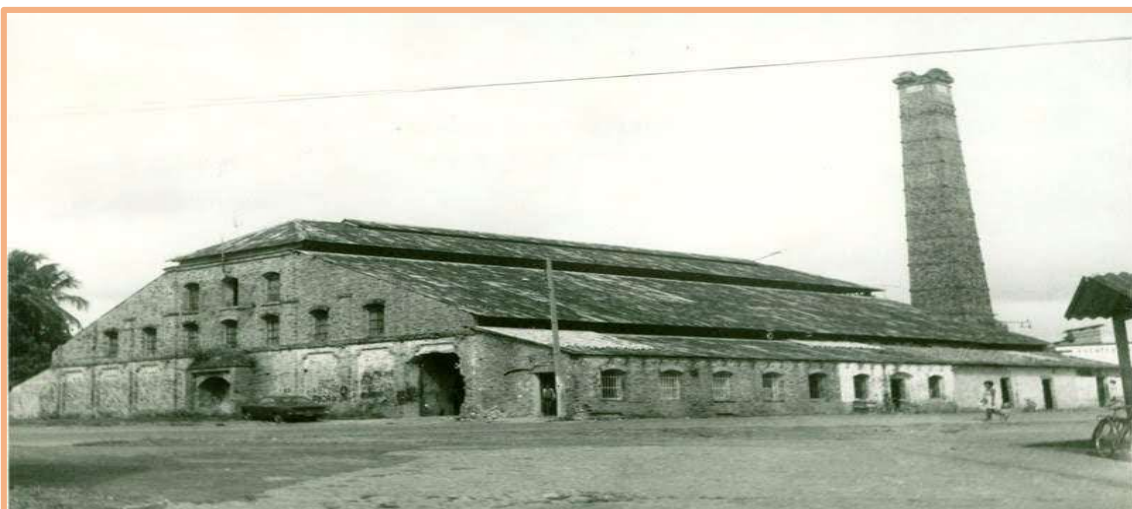
IMAGEM 06- Vista da lateral direita do Engenho Central. FONTE: Biblioteca IBGE. Disponível em: https://www.google.com/search?q=engenho+central+de+pindare+antigo&tbm=isch&ved=2ahUKEwiZrKWFjr3xAhXAm5UCHbYvDhIQ2 . Acesso: 10 de maio,2021.
