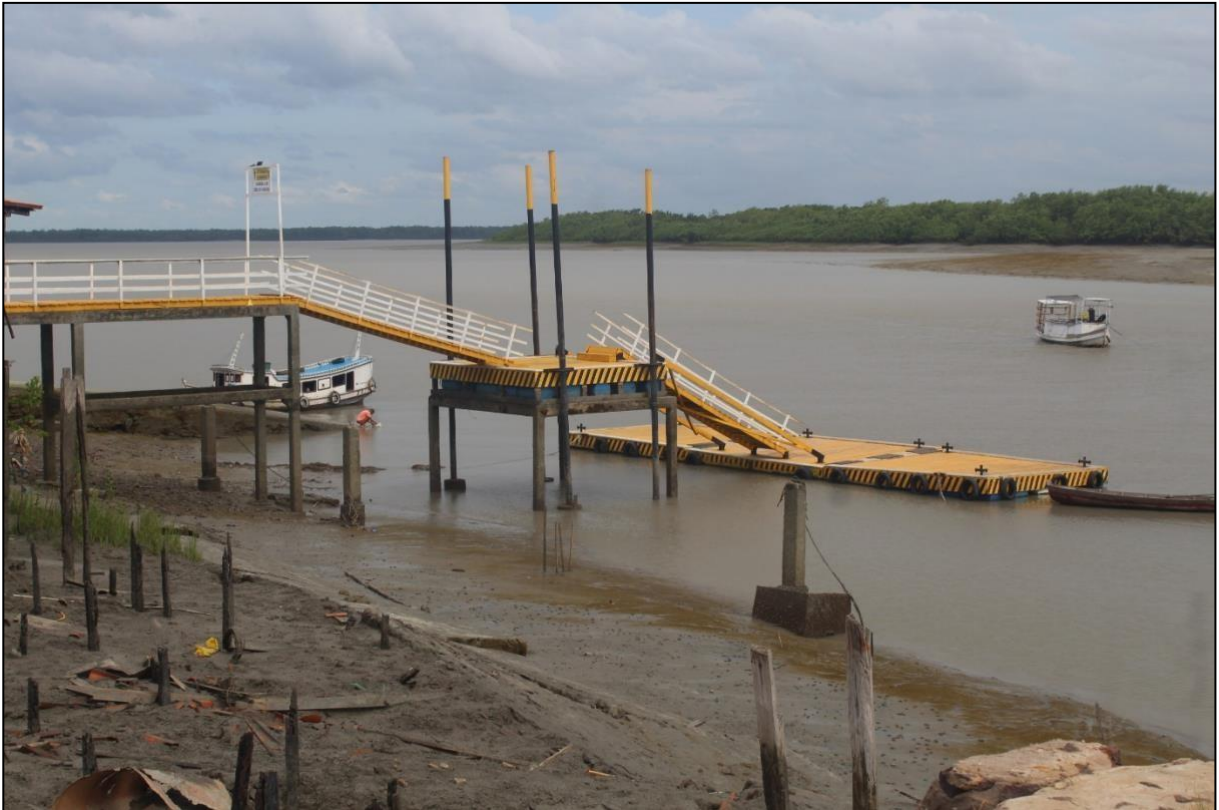
Figura 6 - Presença da unidade Depósitos de pântanos e mangues no rio São João, afluente do rio Turiagu, no município Turiagu, Ponto 7
