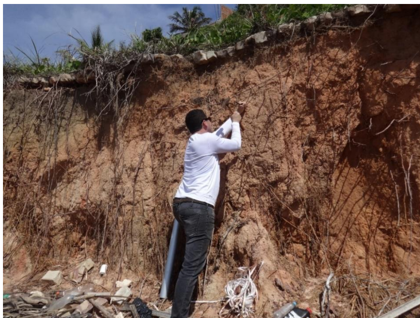
Figura 25 - Fixação dos pinos na falésia de Panaquatira.
