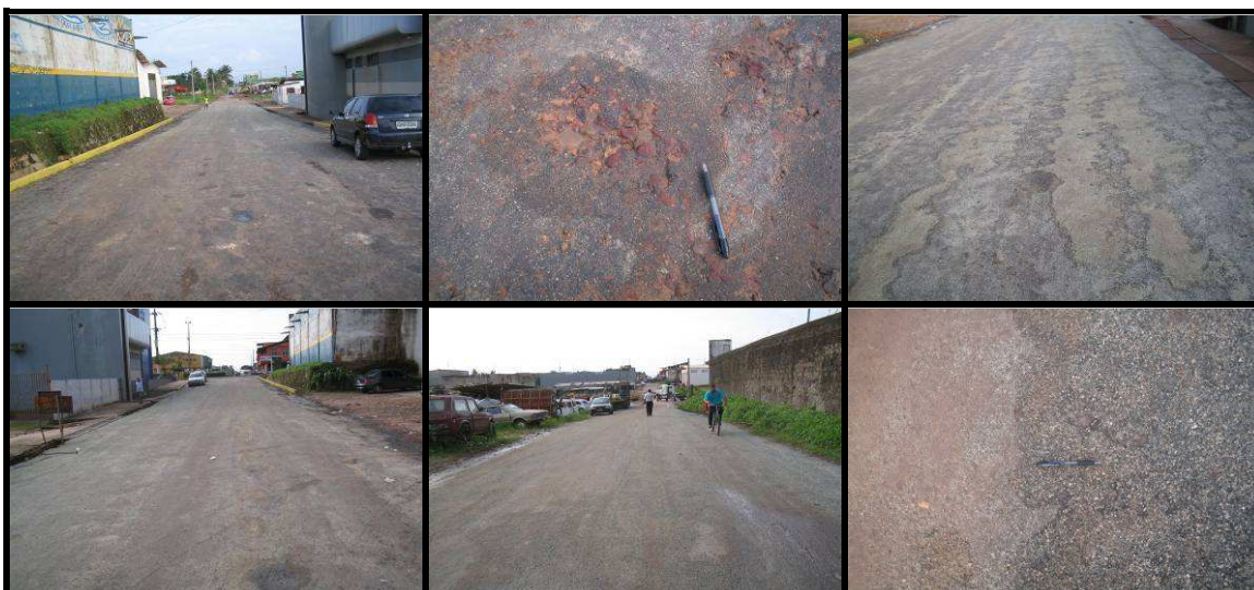
Figura 7.7 – Capa selante na Rua Treze do Engenho após 30 dias de sua execução
