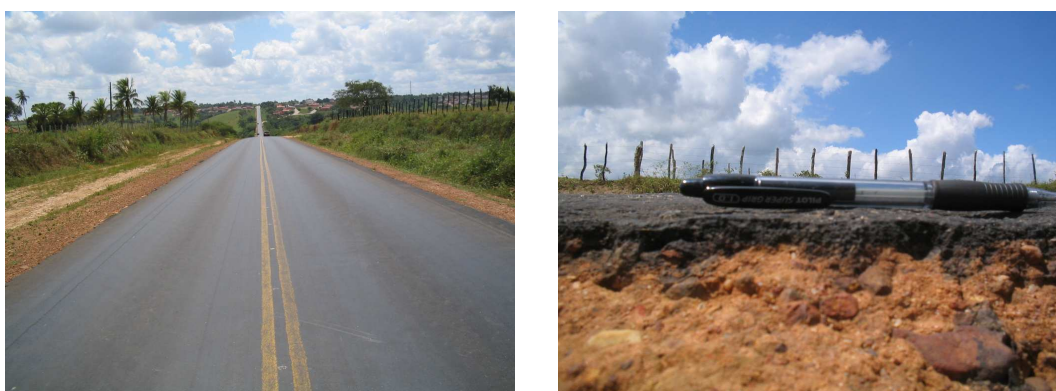
Figura 2.3 – Trechos em TCP na Bahia. Detalhe TCP sobre base de laterita.
