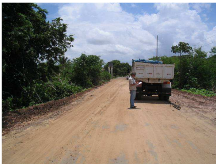
Figura 7.13 – 1º Levantamento deflectométrico – Fev/2007
