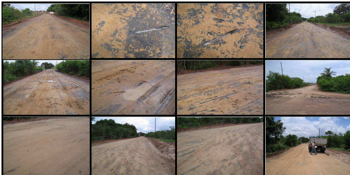
Figura 7.9 – Aparência do trecho experimental nos dias subsequentes à construção
