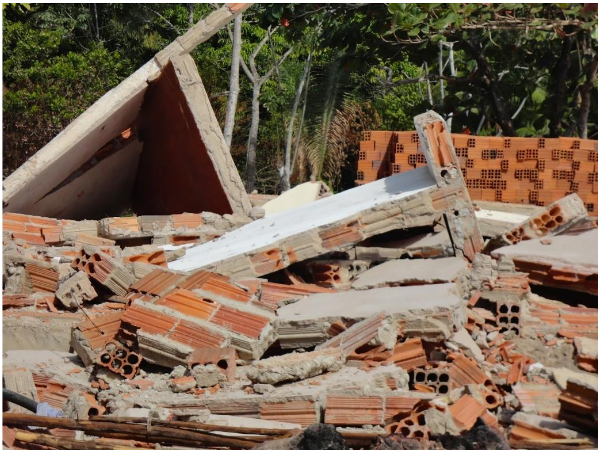
Figura 7: Casa derrubada na Comunidade do Cajueiro.
