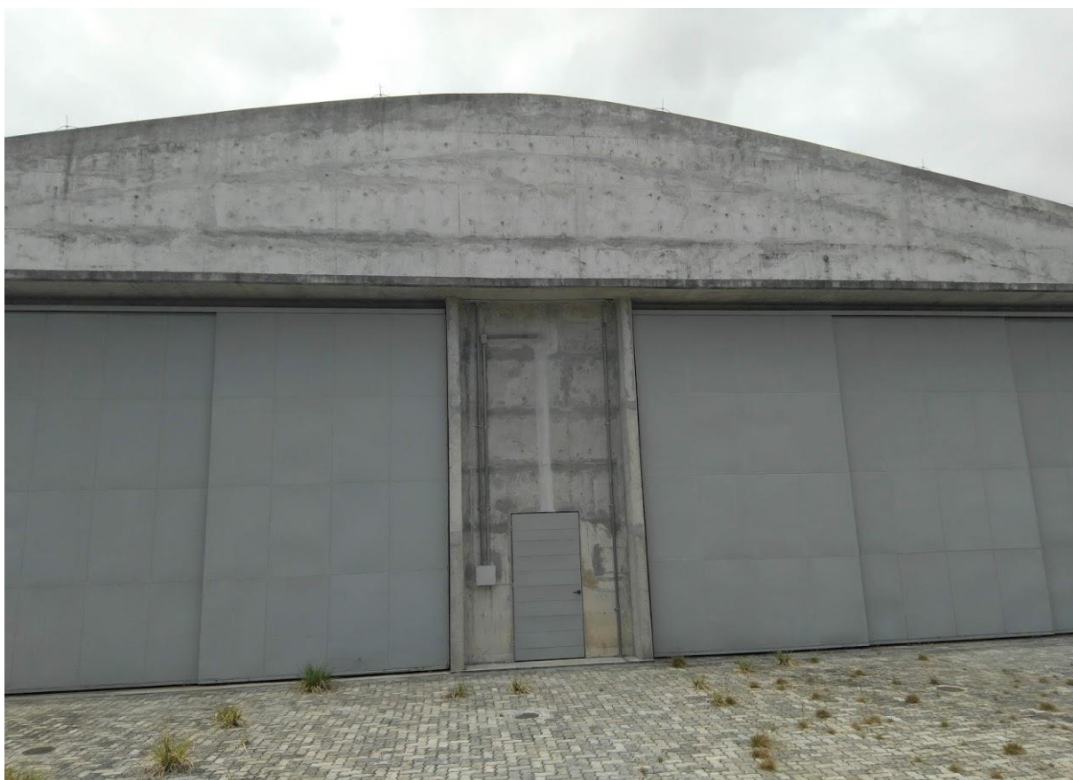
Figura 17 – Vista Frontal do Prédio Depósito de Propulsores do Setor de Preparação e Lançamento.
