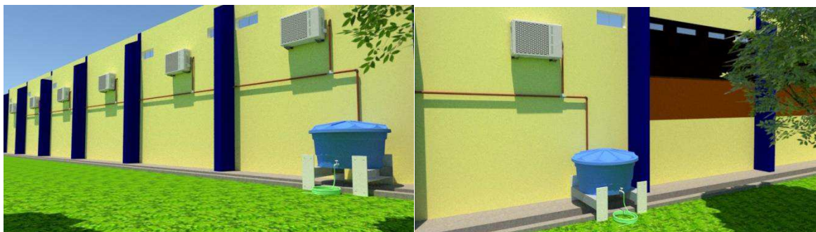
Figura 4.9 – Conexão de PVC ligando cada aparelho até o reservatório (Autor, 2018).
