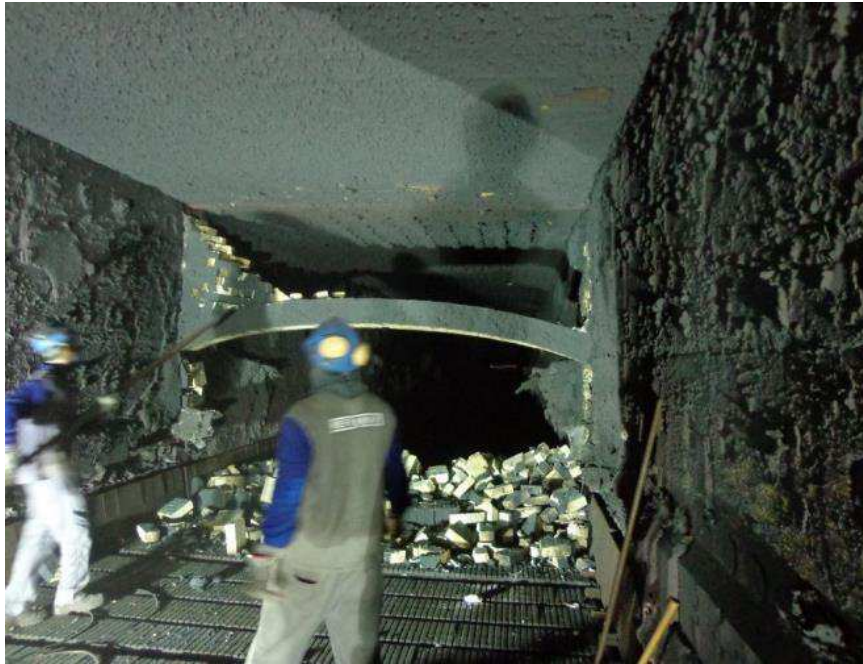
Figura 37 – Demolição da parede divisória do Forno e caixa d'água transversal.
