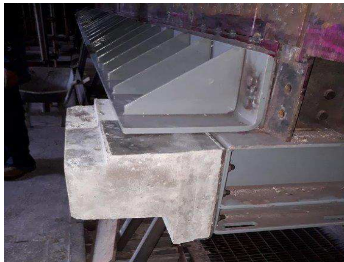
Figura 33 – Detalhe os consoles de sustentação e caixa seca interna.
