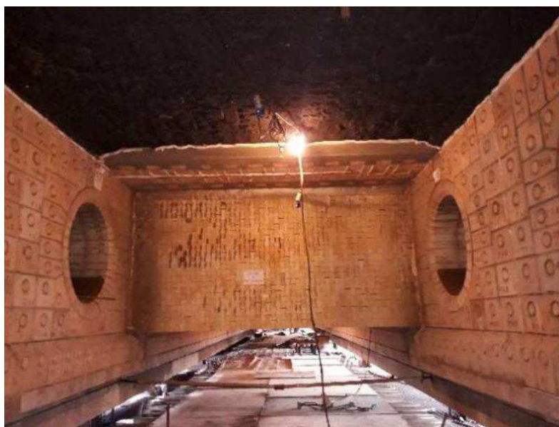
Figura 43 – Parede divisória instalada.
