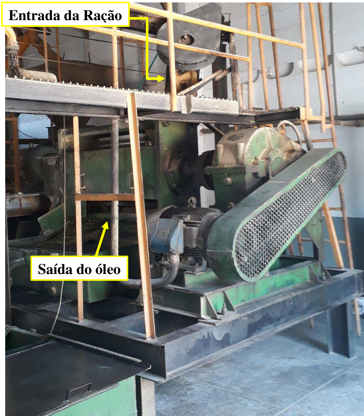
Figura 4.13 – Entrada da ração e saída do óleo contido no moinho (Fonte: Autor).
