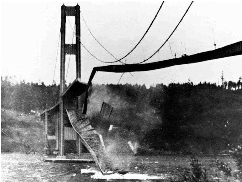
Figura 2.5 – Ponte de Tacoma Narrows durante colapso (RAO, 2008).
