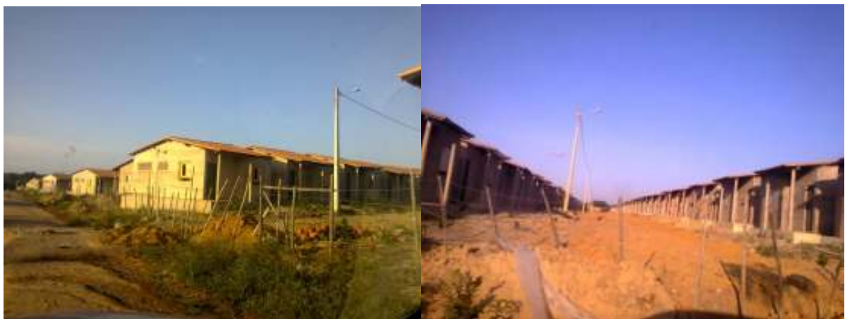
Figura 8 - Construções do Programa MCMV. Fonte: MASULLO, 2012.
