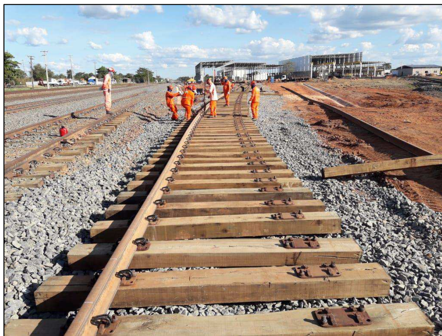
Figura 2 – Construção de grade ferroviária.
