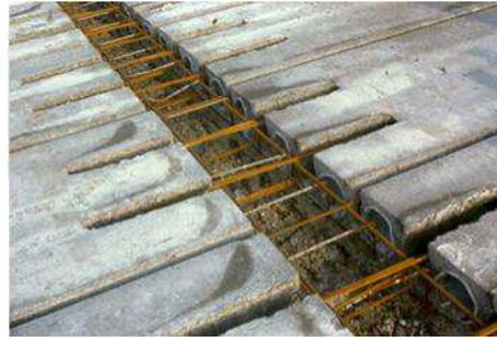
**Figura 2.18 – Transferência de cisalhamento por meio de estribos e atrito. [Ferreira (2008) ]**
