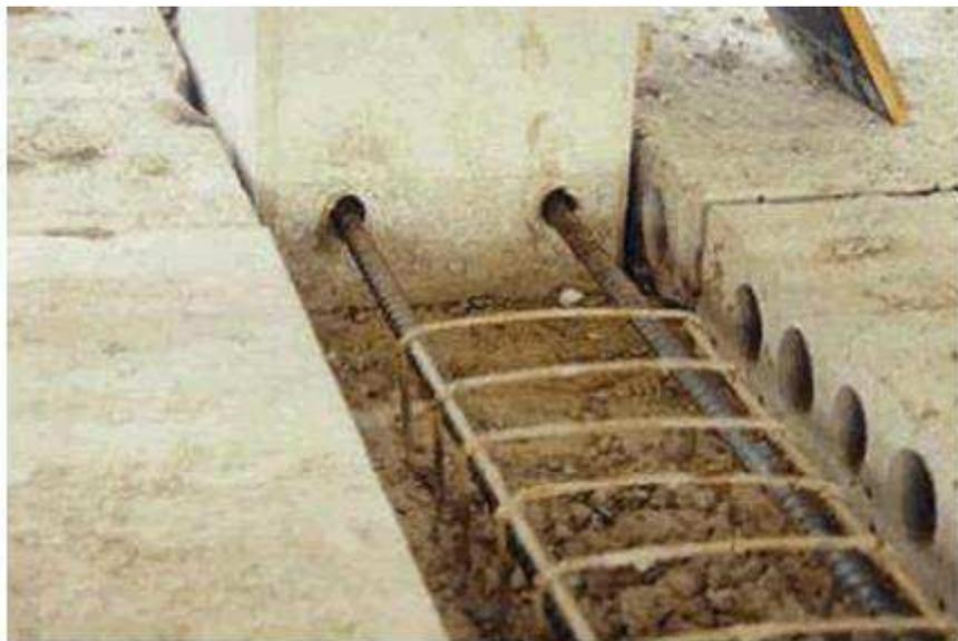
**Figura 2.41 Detalhe da solução com armadura de solidarizarão com barras (FONTE: FERREIRA, 2007)**
