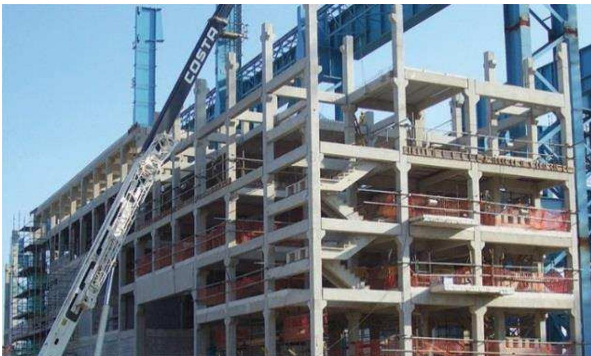
**Figura 2.38 – T&A Pré-fabricados – Estruturas em esqueleto** Hadade (2016).
