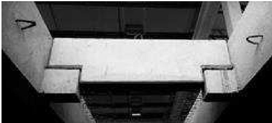
*Figura 2.27- Ligação dente Gerber-consolo. El Debs (2000).*
