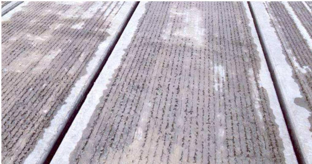
**Figura 2.9 – Superfície rugosa em lajes alveolares [Ferreira (2008)]**
