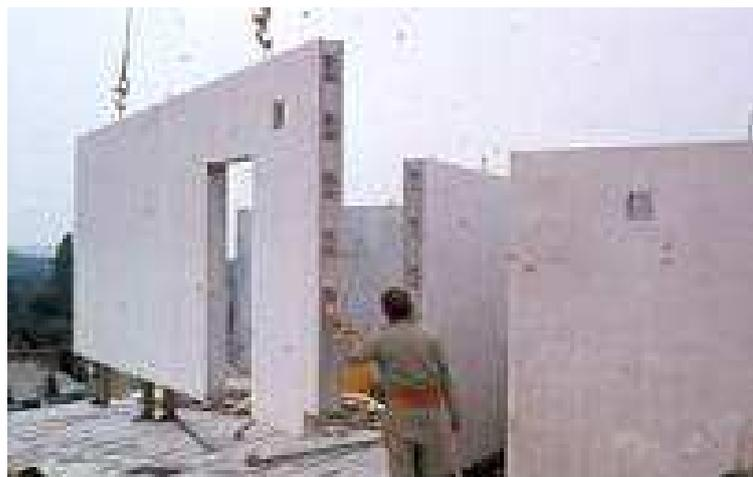
**Figura 2.11 – Paredes de concreto ligadas pelas chaves de cisalhamento. Ferreira (2008) ]**
