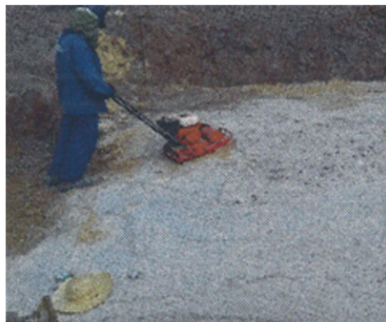
b) Escavação e melhoramento do solo;
