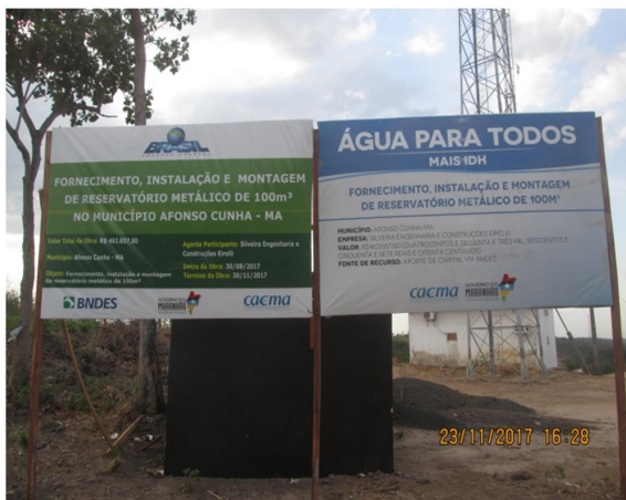
a) Instalação da placa da obra e de barracão;
