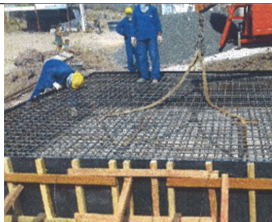
d) Montagem da armadura;
