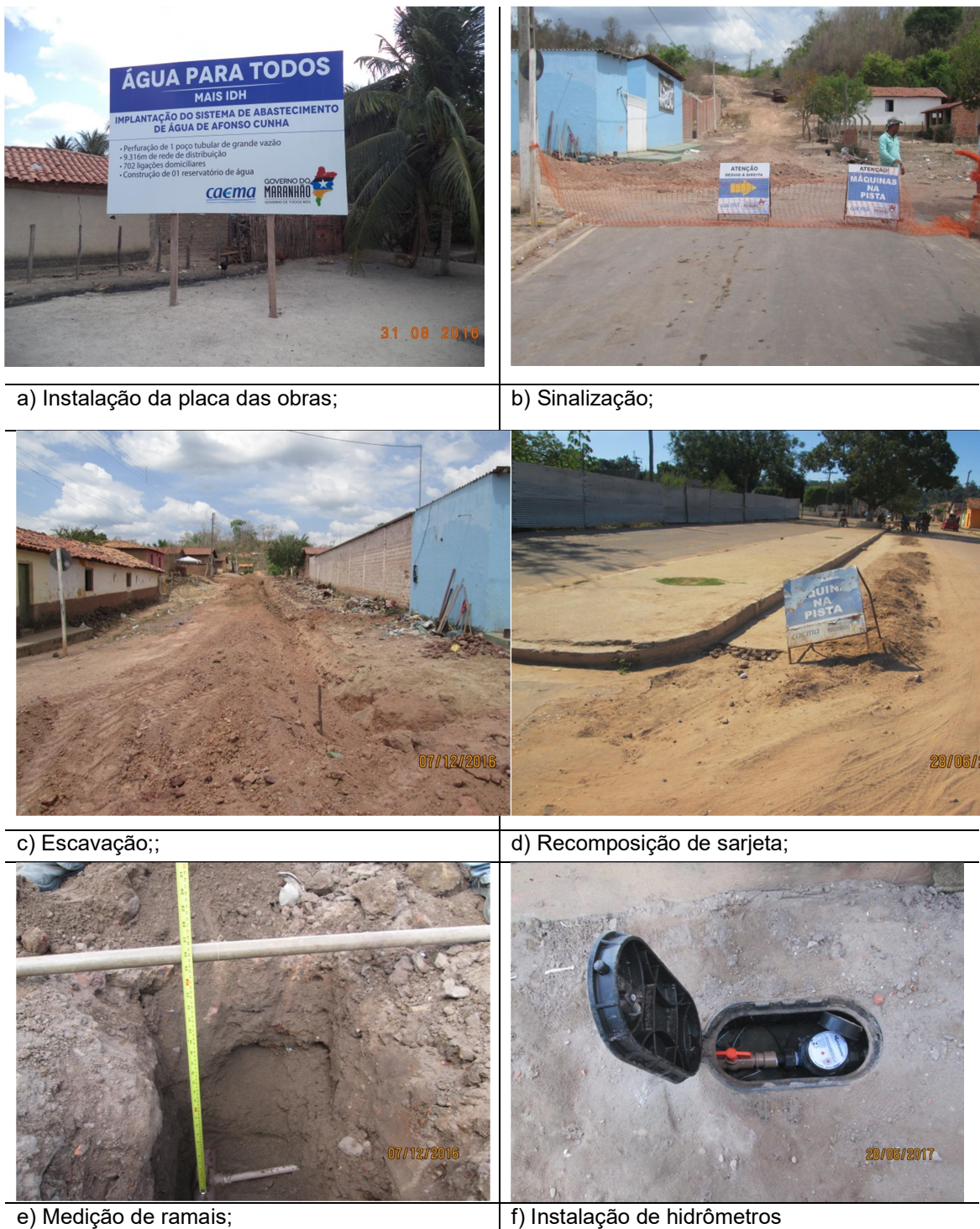
Figura 10 - Execução da rede/adutora
