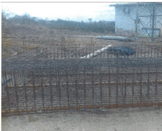
c) Corte e dobra para montagem de armadura;
