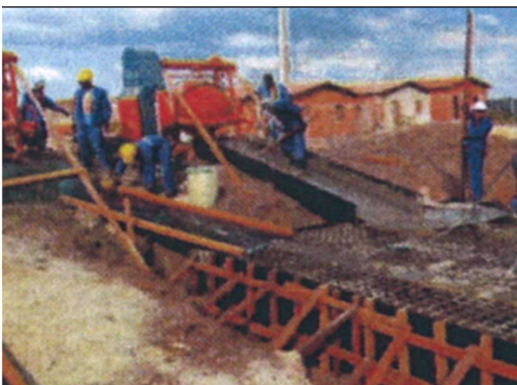
e) Concretagem da base;
