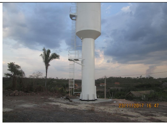
f) Instalação do reservatório
