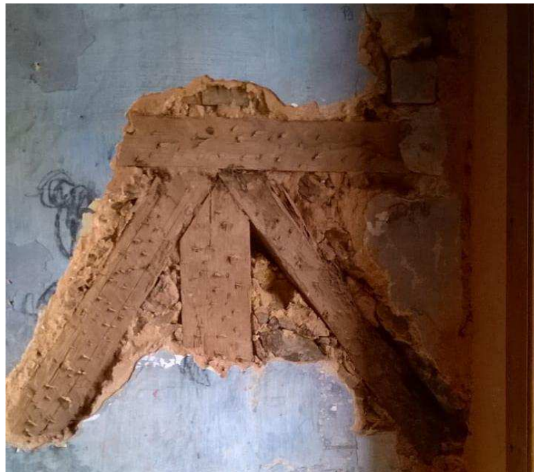
Fotografia 24 – Alvenaria de pedra argamassada com madeira
