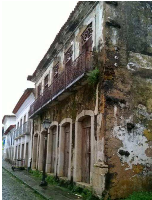
Fotografia 1 – Área de estudo: fachada do sobrado 559
