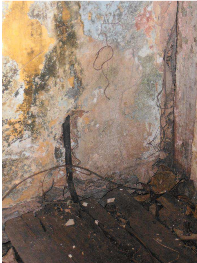
Fotografia 7 – Argamassa de alvenaria de pedra e madeira
