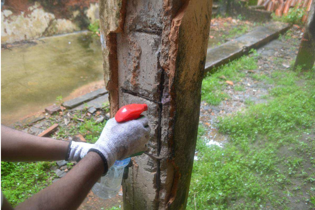
Fotografia 16 – Aplicação de fenolftaleína no pilar de concreto
