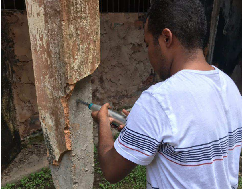
Fotografia 20 – Execução de ensaio esclerométrico em pilar de concreto
