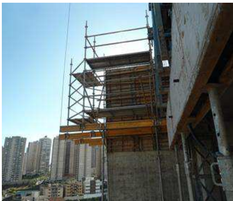
Figura 20 - Andaime em balanço
