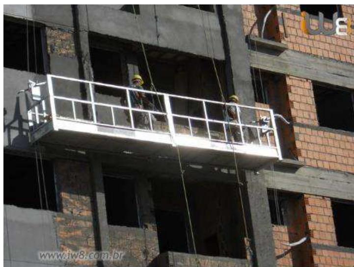
Figura 21 - Andaime suspenso mecânico
