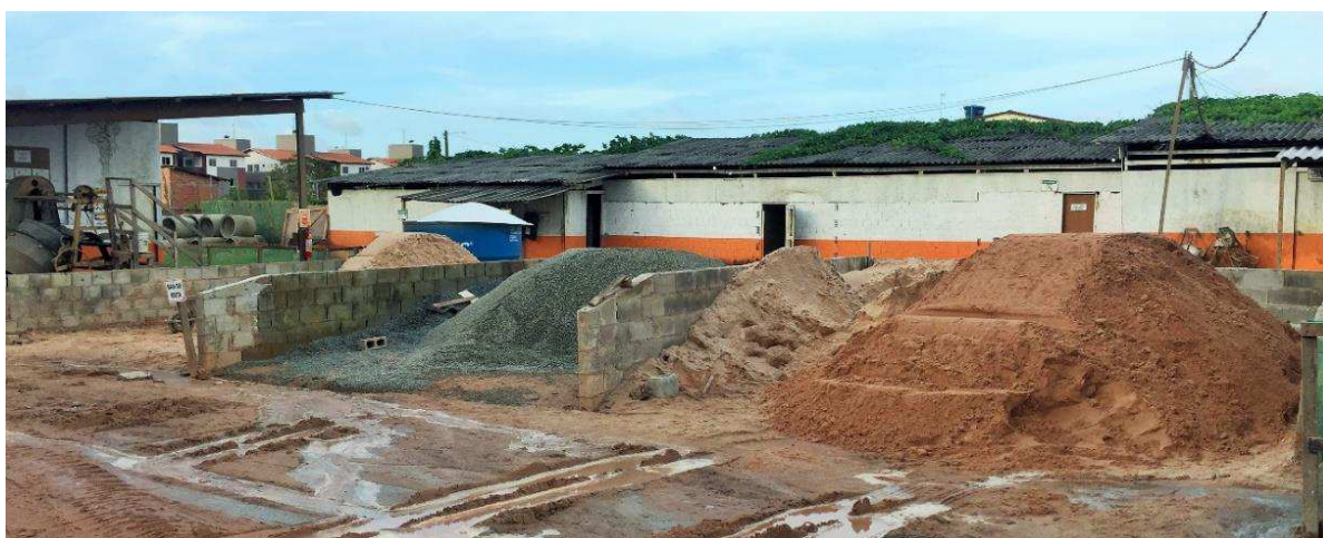
Figura 28 - Armazenamento de agregados
