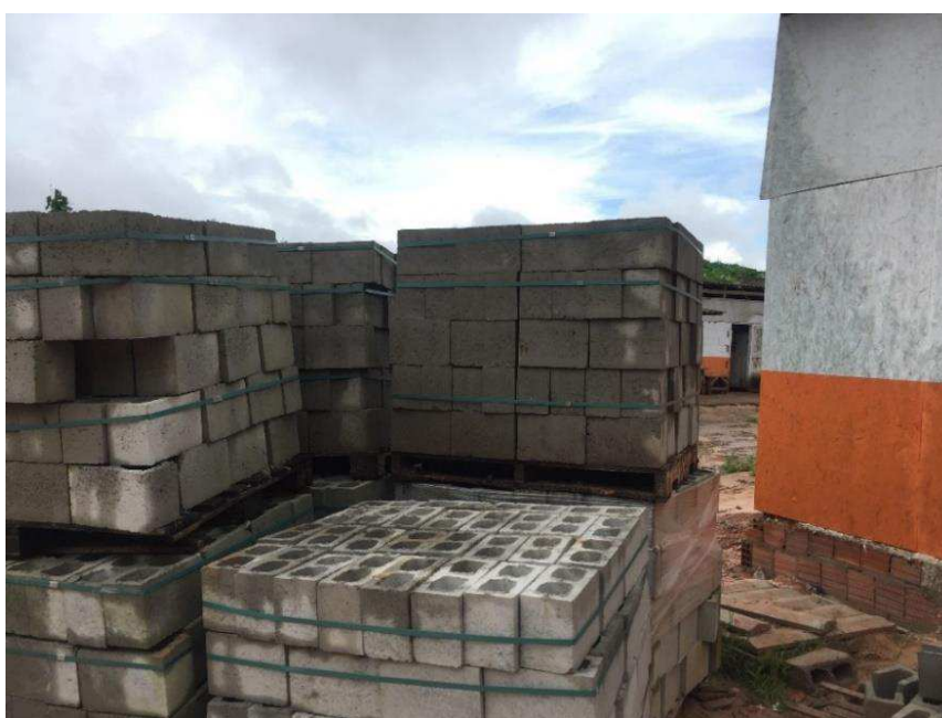
Figura 25 - Armazenamento de blocos de concreto
