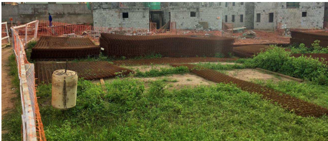
Figura 29 - Armazenamento de armaduras
