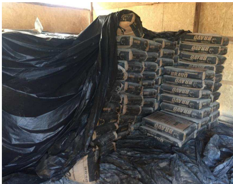
Figura 27 - Armazenamento de cimento
