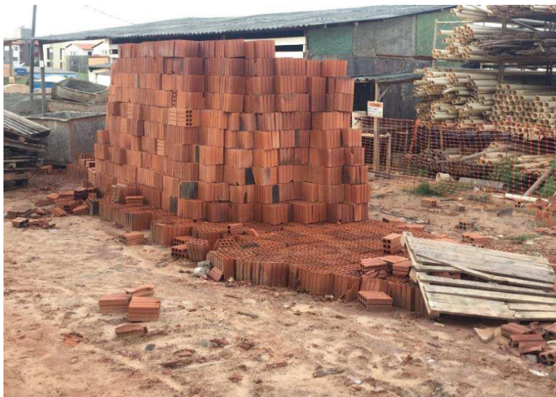
Figura 26 - Armazenamento de blocos cerâmicos
