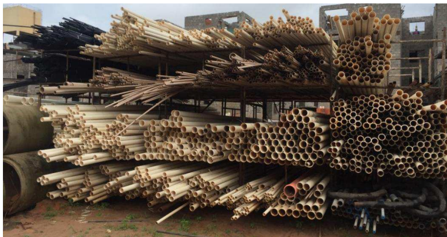
Figura 30 - Armazenamento de tubos de PVC
