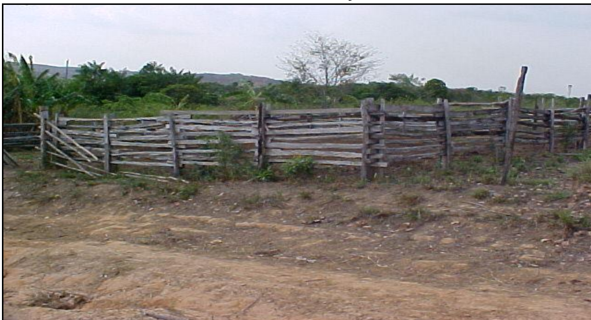
FIGURA 8 – Curral em mal estado de conservação em Zé Doca - MA
