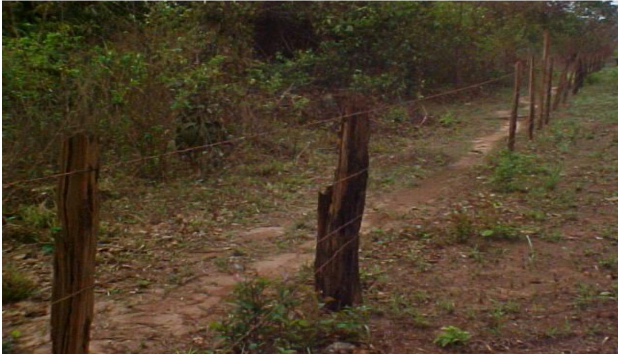
FIGURA 7 – Cerca em mal estado de conservação em Codó – MA
