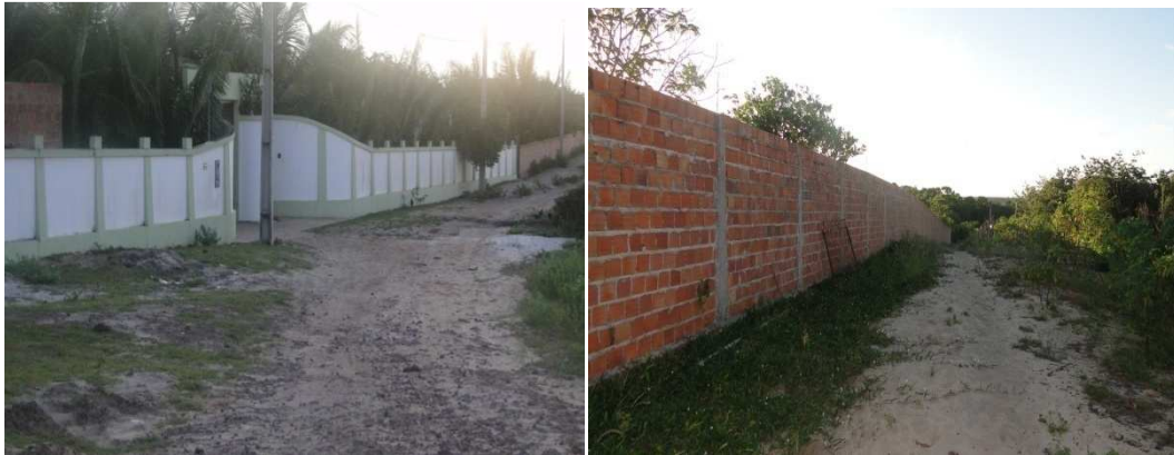
Fotos 15 e 16 - Os muros que se erguem
