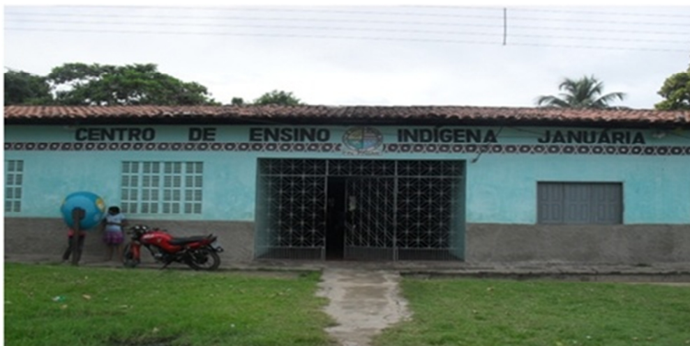
Figura 12 – Fachada da escola. Fonte: Fonte: Pinto/2011.
