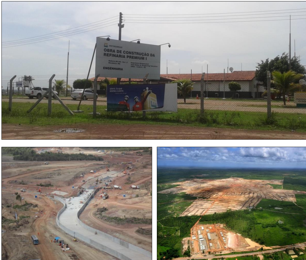
Figura 21- Sede da Refinaria, 2015; Canteiro de obras em 2012; Vista aérea da Premium em 2012.
