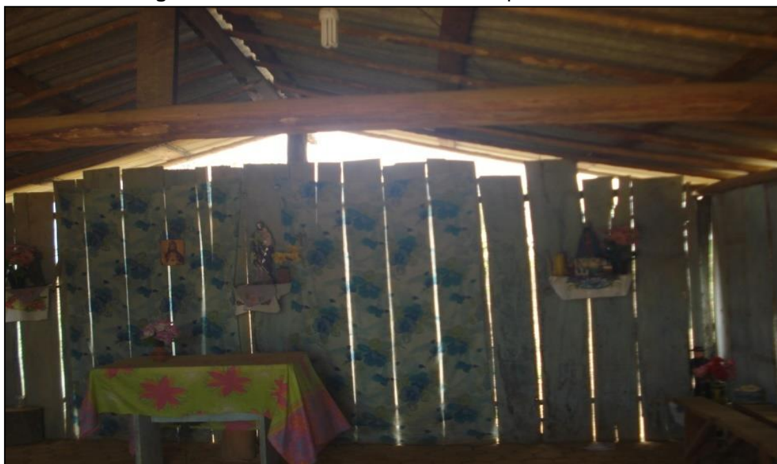
Figura 18 - Estrutura física interna da Capela de São José
