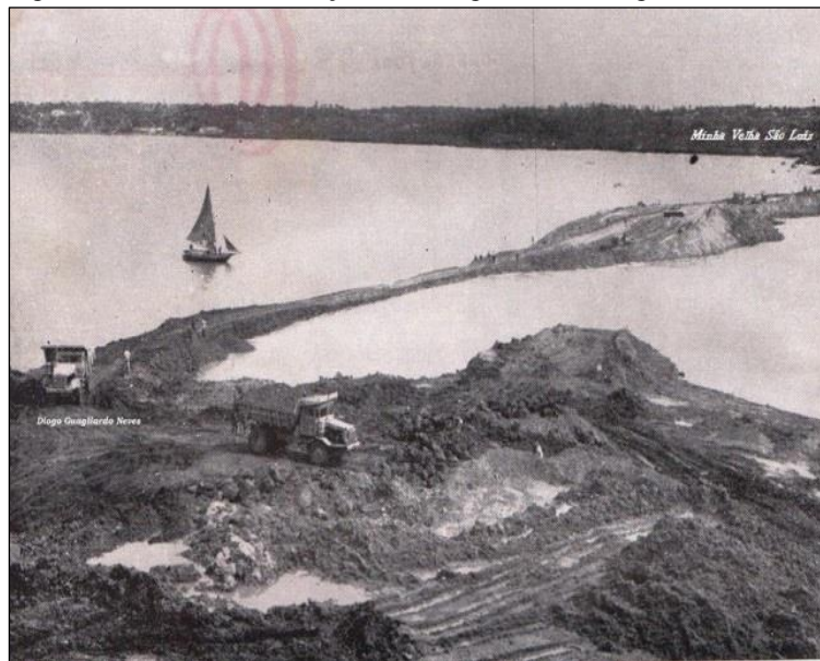
Figura 6 - Obras de construção da barragem do Bacanga
