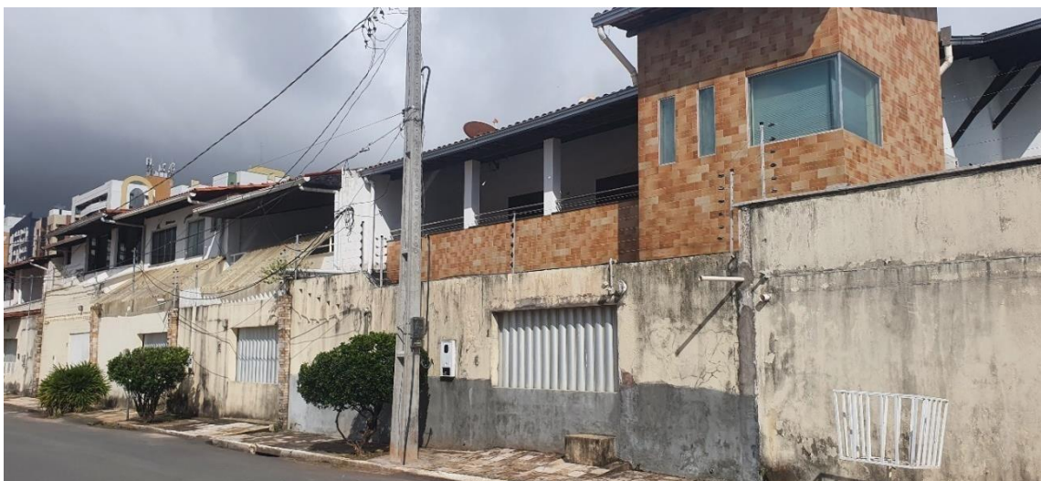
Figura 41 – Meia parede construída na frente do portão para evitar que a água da chuva adentre as residências da Lagoa da Jansen.
