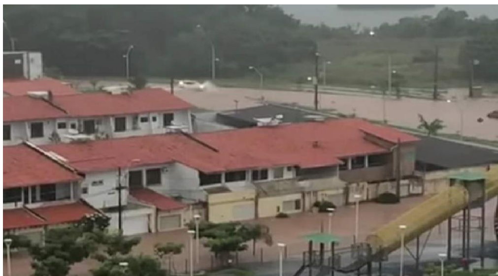
Figura 42 – Alagamento após fortes chuvas, nota-se que a água chega a uma grande altura do muro.
