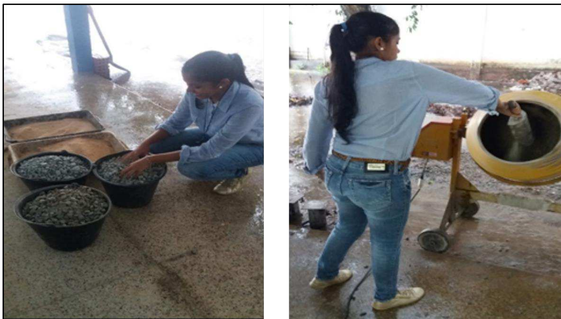
Figura 19 - Preparação dos agregados para serem levados à betoneira
