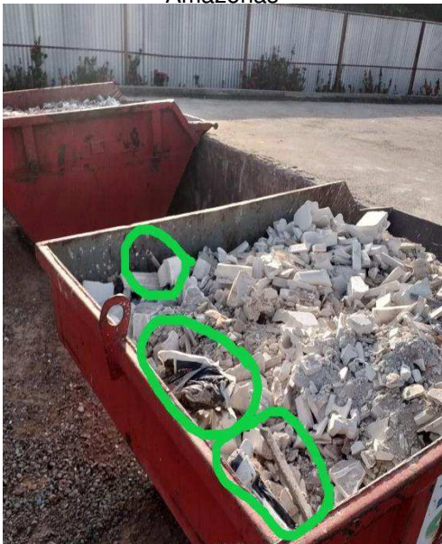
Figura 09 - Ecoponto, Parque Amazonas
