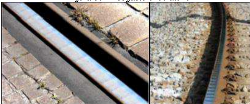
Figura 30 - Desgaste ondulatório.
