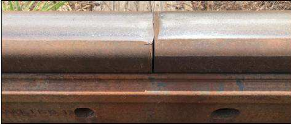
Figura 44 - Ausência de espaçamento entre os trilhos.
