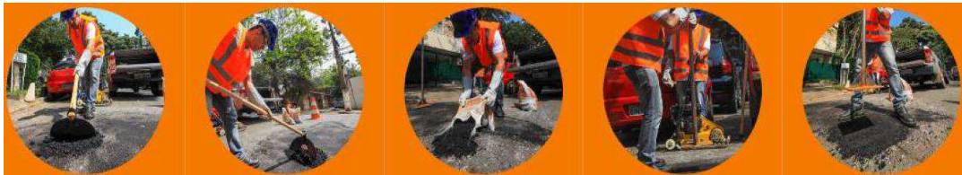
Figura 13 - Etapas – Aplicação do CAUQ Estocável
