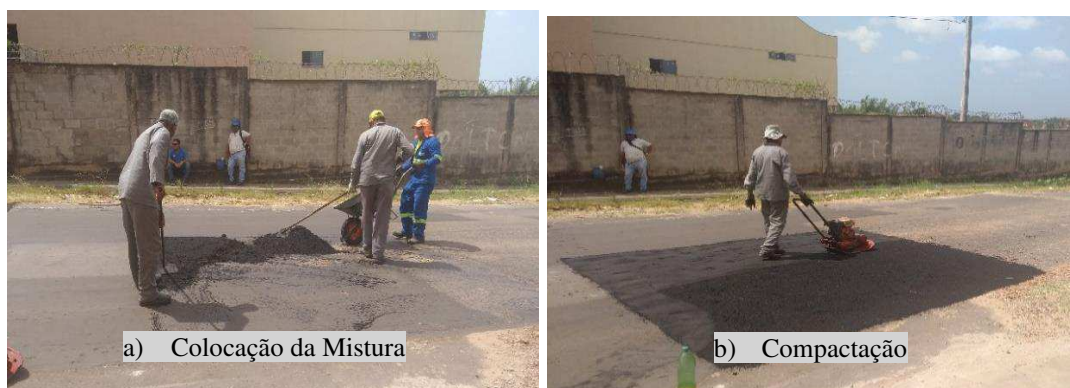
Figura 7 - Operação Tapa-buraco com AAUQ
