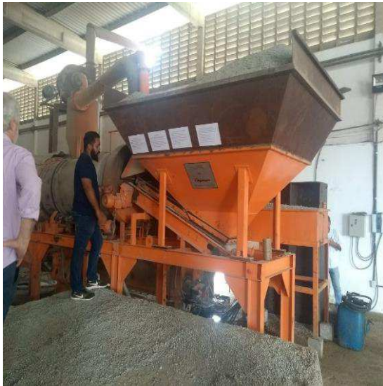
Figura 3 - Usina de asfalto CAUQ
