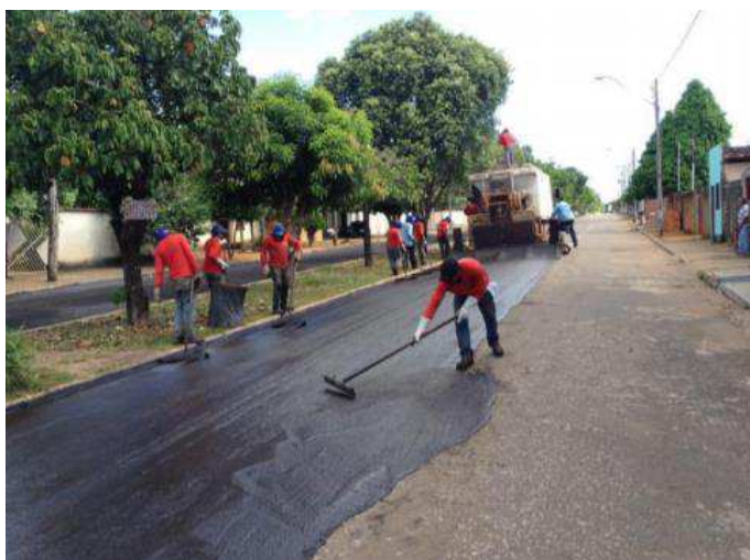
Figura 11 - Exemplo de aplicação de lama asfáltica em Porto Nacional - TO
