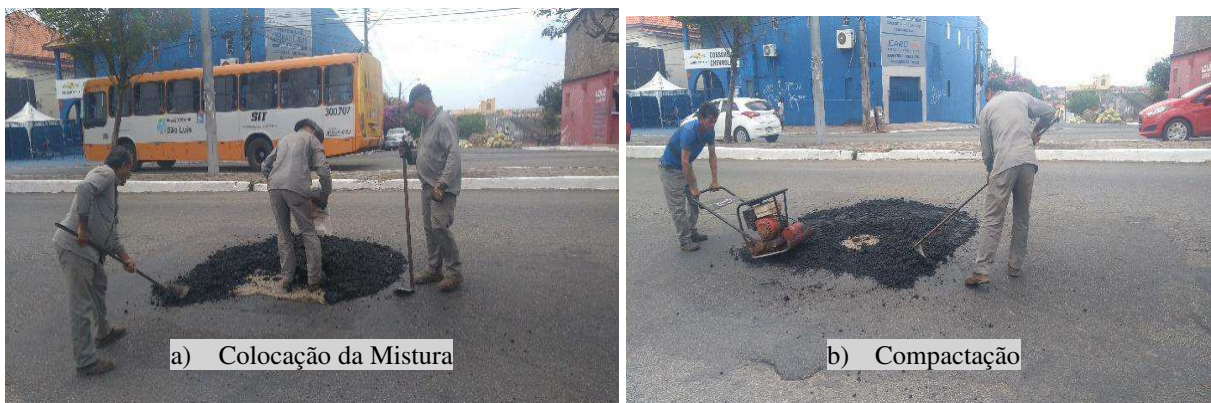
Figura 6 - Operação Tapa-Buraco com CAUQ Estocável
