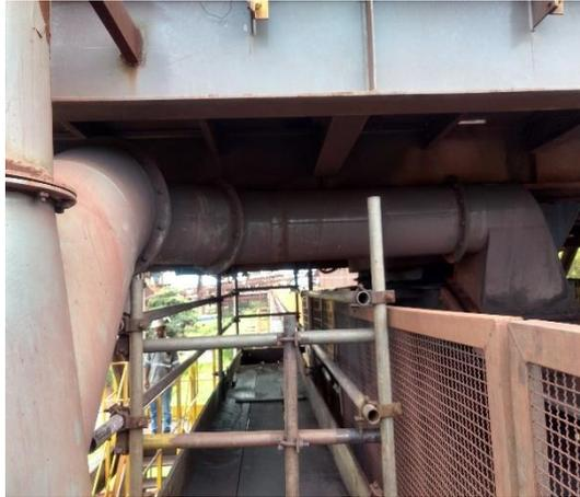
Figura 67. Caminho do material particulado para o terceiro ponto de captação.
