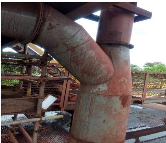
Figura 68 (a). Encontro de material particulado, vista lateral.
