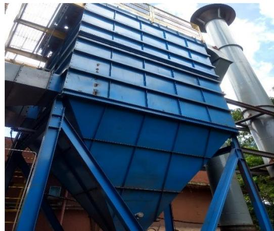
Figura 50 (b). Filtro de manga usado no despoeiramento em transferência de transportadores.
