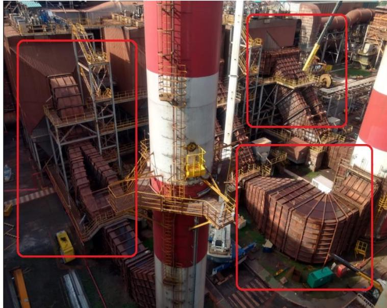
Figura 47. Mapeamento dos 3 Precipitadores no processo.
