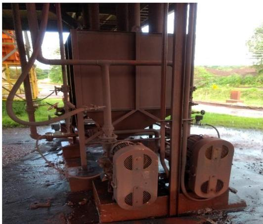
Figura 77 (a). Bombas de água do lavador venturi.
