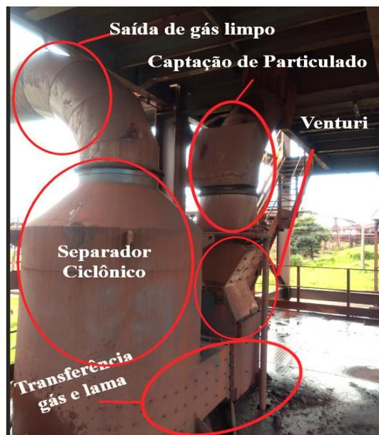
Figura 73. Fenômenos de separação gás e lama.
