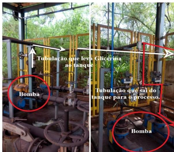
Figura 89. Caminho da glicerina-tanque e tanque-processo.
