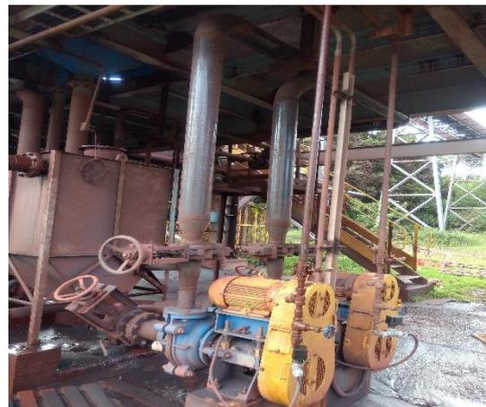
Figura 77 (b). Bombas de sucção de lama para o espessador e tubulação.
