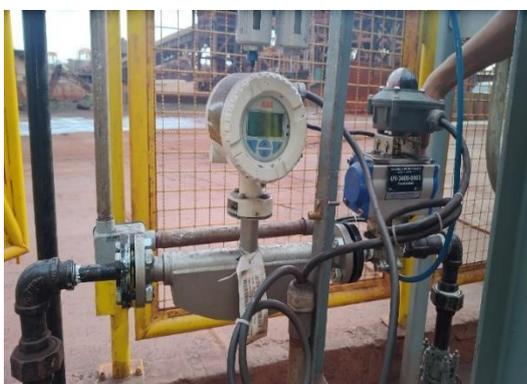
Figura 105. Medidor Coriolis no sistema de Glicerina.
