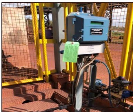
Figura 104. Medidor de vazão magnético (Utilizado antes).
