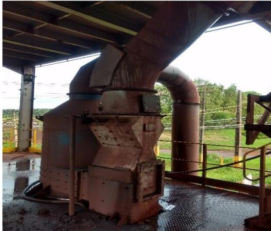
Figura 71. Chegada do material particulado no lavador venturi.
