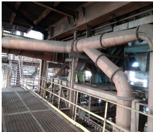
Figura 25. Tubulação de captação de material particulado na entrada do forno.
