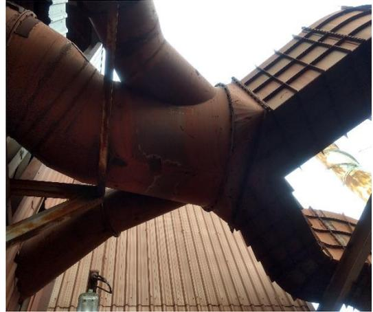
Figura 30 (b). Derivação de captação para o lavador de gás.
