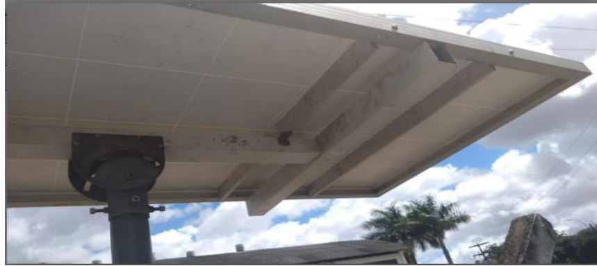
Figura 4.9 - Dissipadores instalados na placa fotovoltaica.
