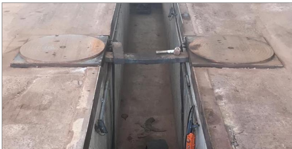
Figura 3.26 – Fosso de inspeção sub-veicular (Elaborado pelo autor, 2019)
