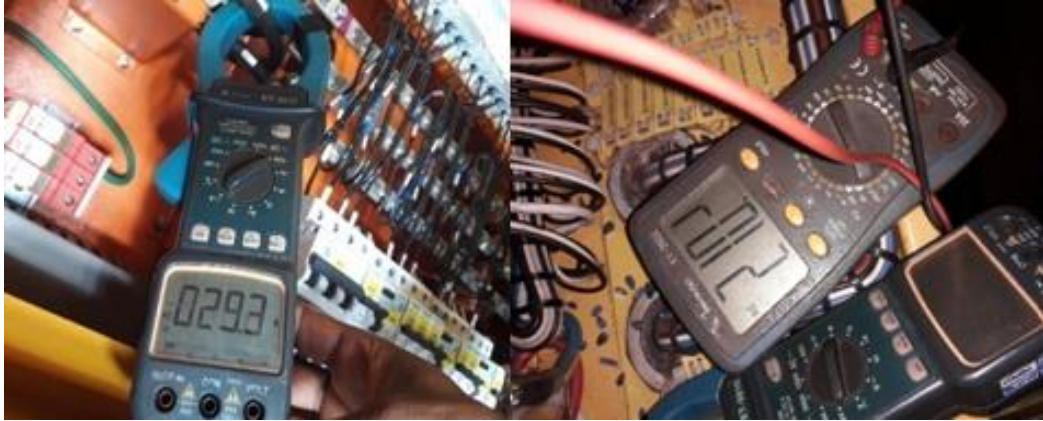
Figura 4.17 – Realização dos testes de pré-comissionamento (Elaborada pela autora, 2019)
