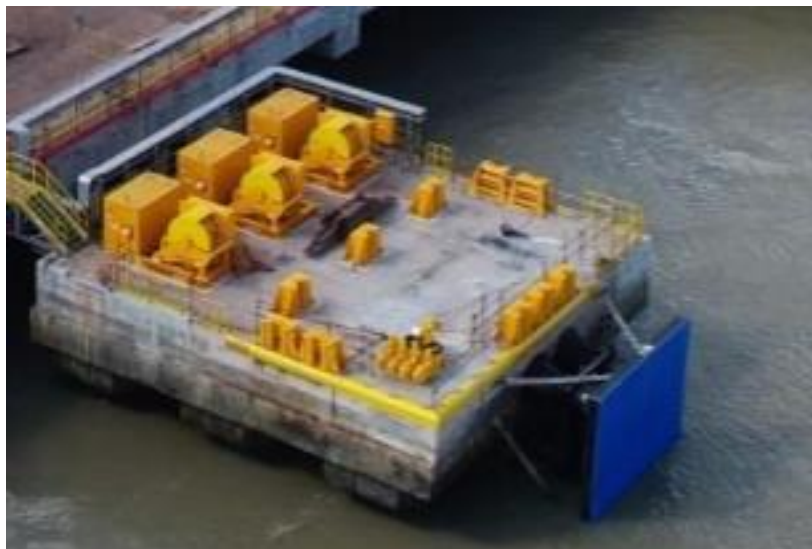
Figura 3.6 – Visão geral do dolphin de atracação (Adaptado de Vale, 2019)
