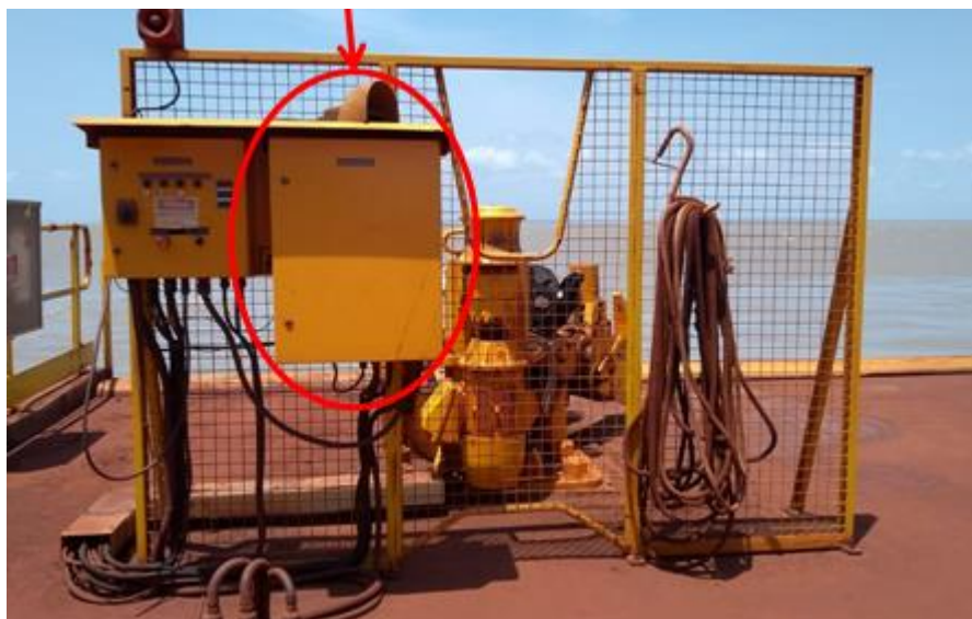
Figura 4.11 – Painel de I/O Remoto (Elaborada pela autora, 2019)
