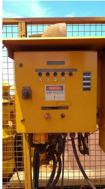
Figura 4.10 – Painel de Controle Local (Elaborada pela autora, 2019)
