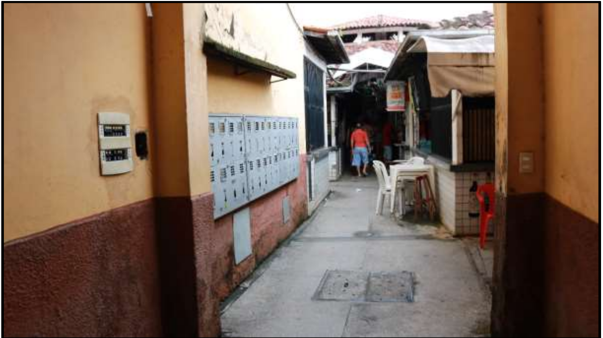
Figura 23 – Dimensionamento da rede elétrica, presença de infiltrações.
