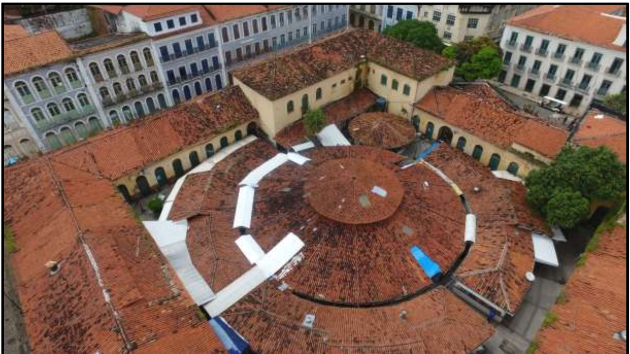
Figura 14 – Entorno do mercado, aglomeração de edificações.
