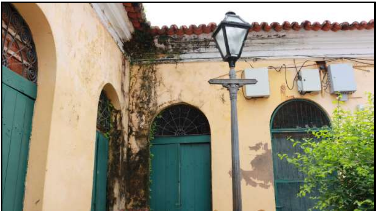
Figura 24 – Infiltração, fissuras e trincas.
