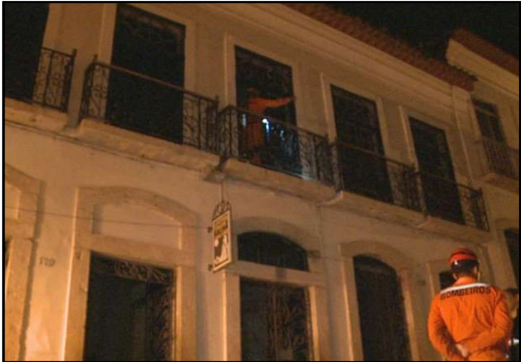
Figura 8 – Pousada na Rua do Giz, Centro Histórico.
