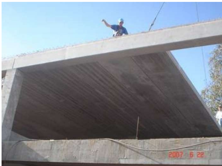
Figura 25 - Posicionamento do painel alveolar
