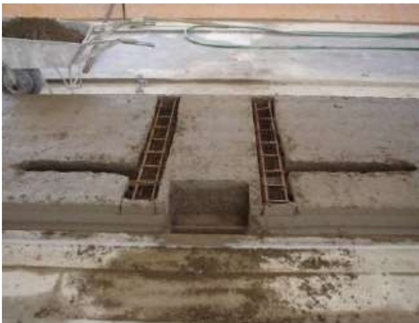
Figura 15 - Reforço na lateral do vão da laje
