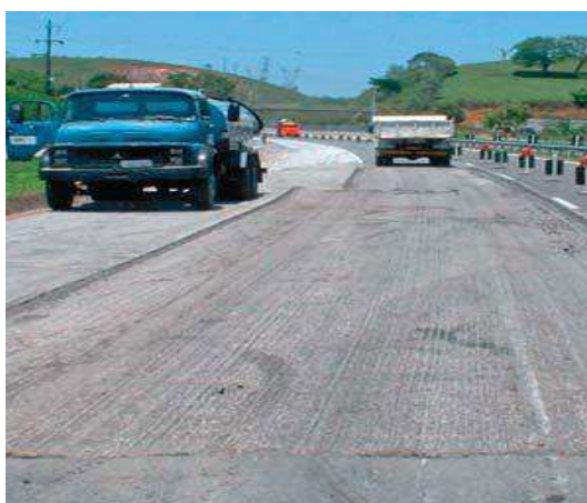
Figura 8- Pista após fresagem
