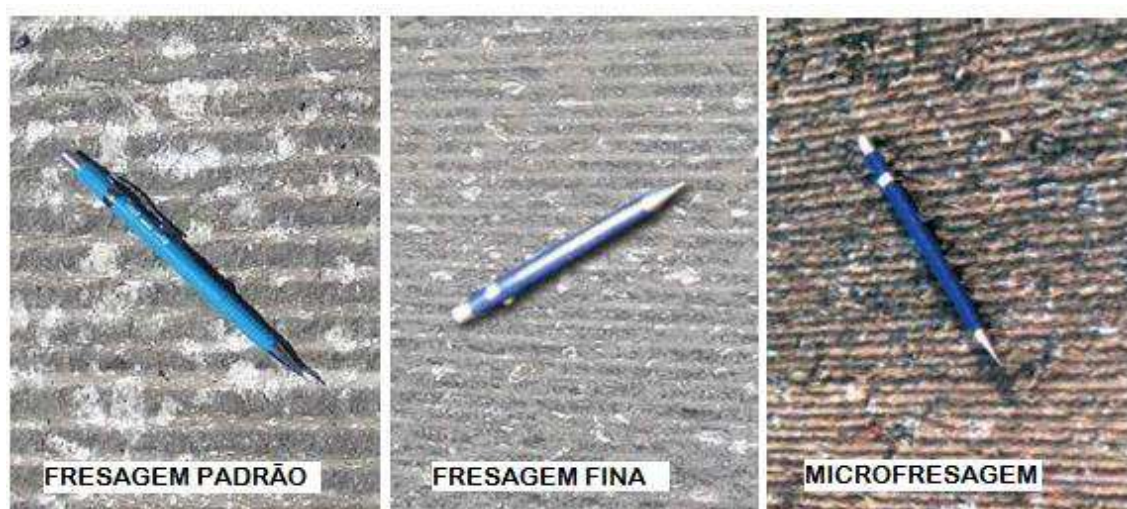
Figura 9-Comparação entre os tipos de fresagem quanto à rugosidade resultante na pista
