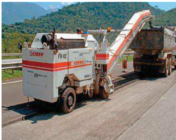
Figura 7- Processo de fresagem e recolhimento do material
