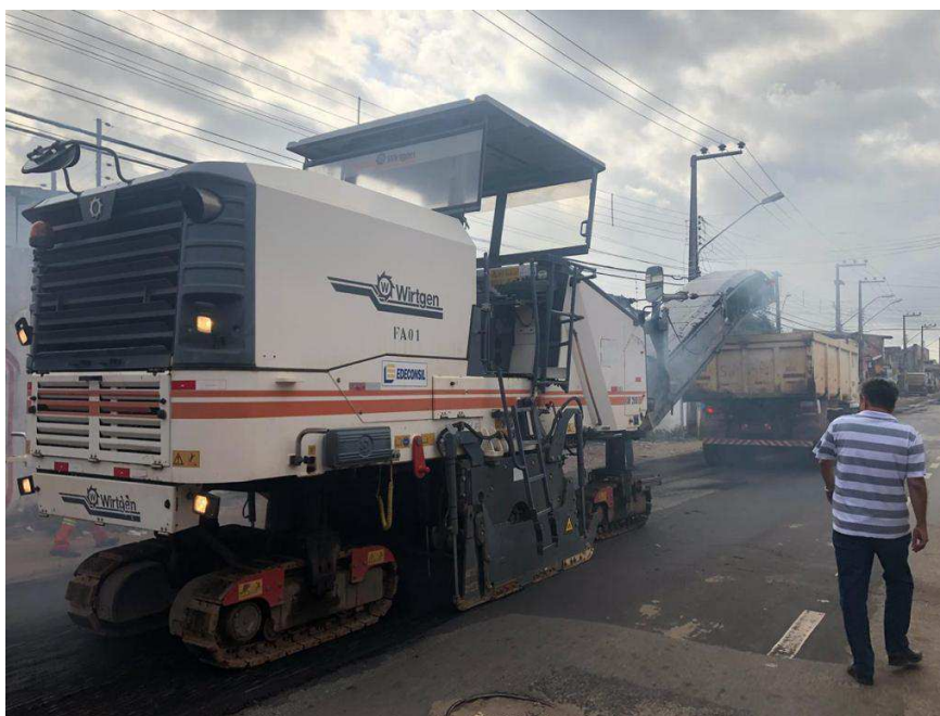
Figura 16- Máquina fresadora Wirtgen
