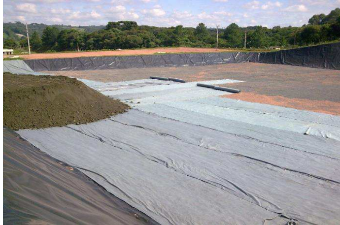
Figura 14: Colchão drenante de geotêxtil
